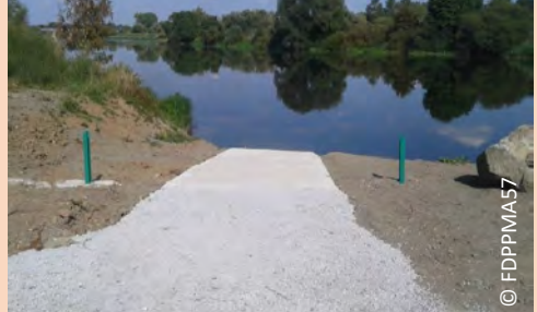
12/09/2016 : rampe de mise à l'eau finalisée
